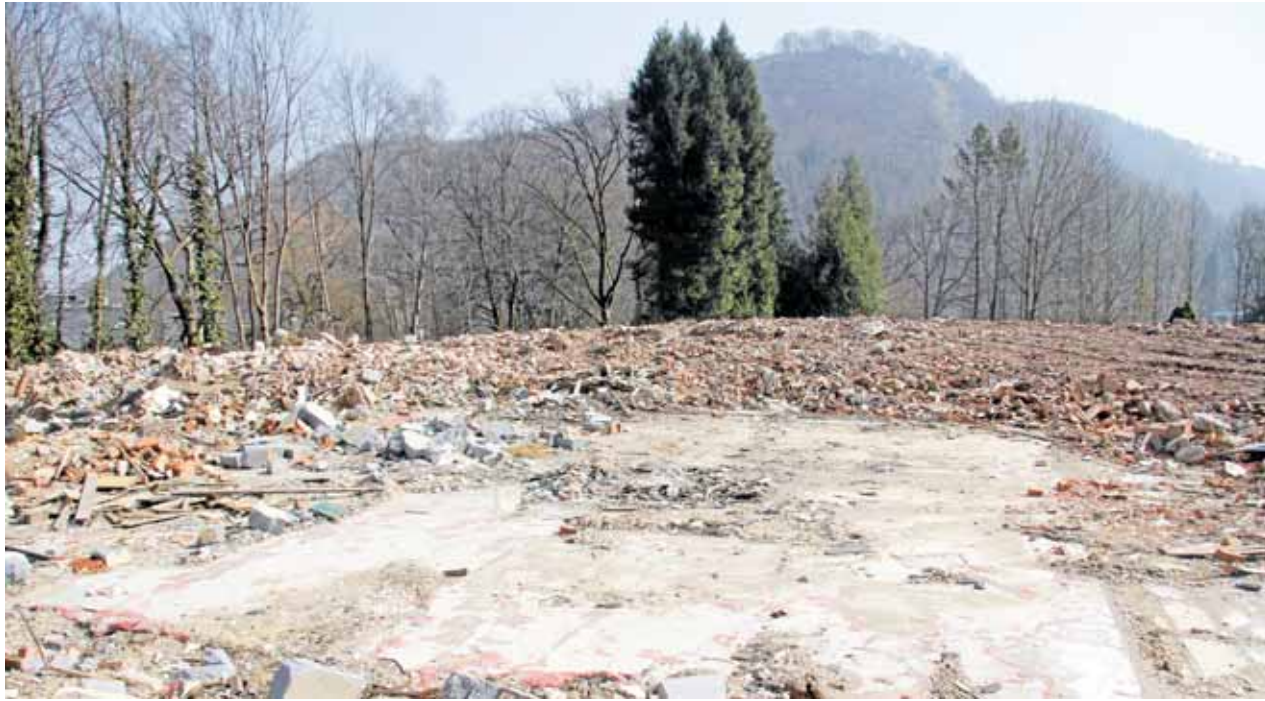
Ein Bauplatz am Waldesrand: Das Areal des Harzburger Hof in diesem Jahr nach Einebnung der Brandruine. Archivfoto: Schlegel
